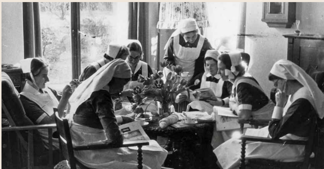
Zusters in het Juliana Kinderziekenhuis. Foto uit 1936, collectie HGA
