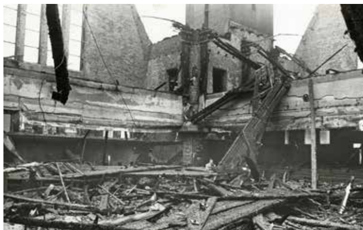
Brandschade van de kerk. Foto: Stokvis, collectie HGA
