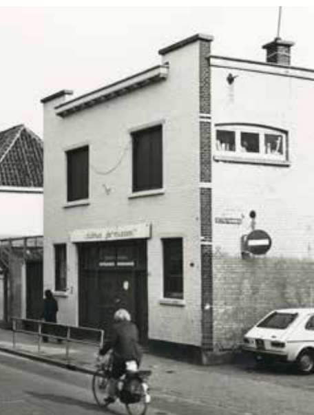
de Mussen gevestigd. Foto uit 1979, Dienst voor de
