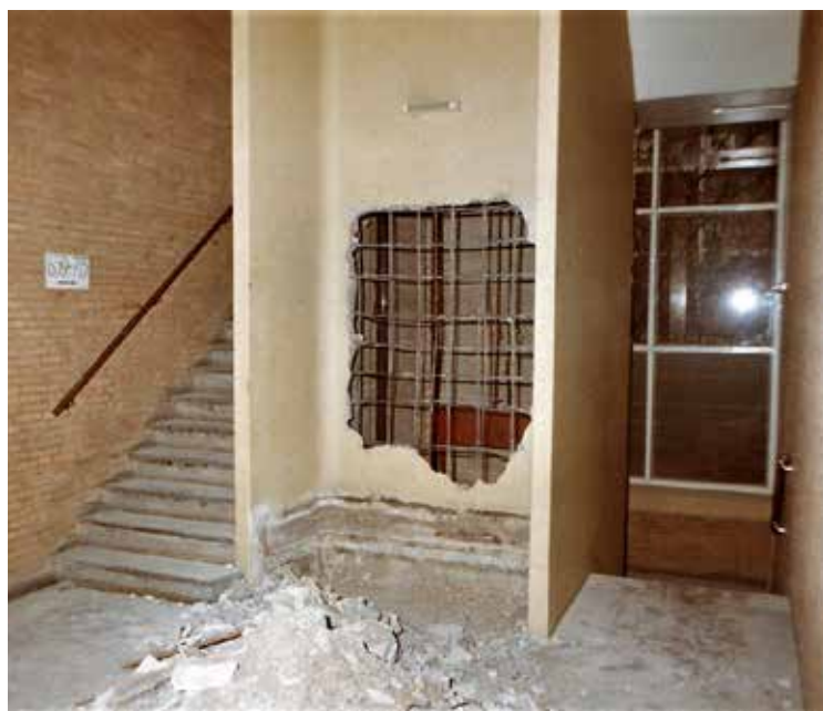
Uitbreken van een muur aan de Meppelweg voor stopplaats lift
