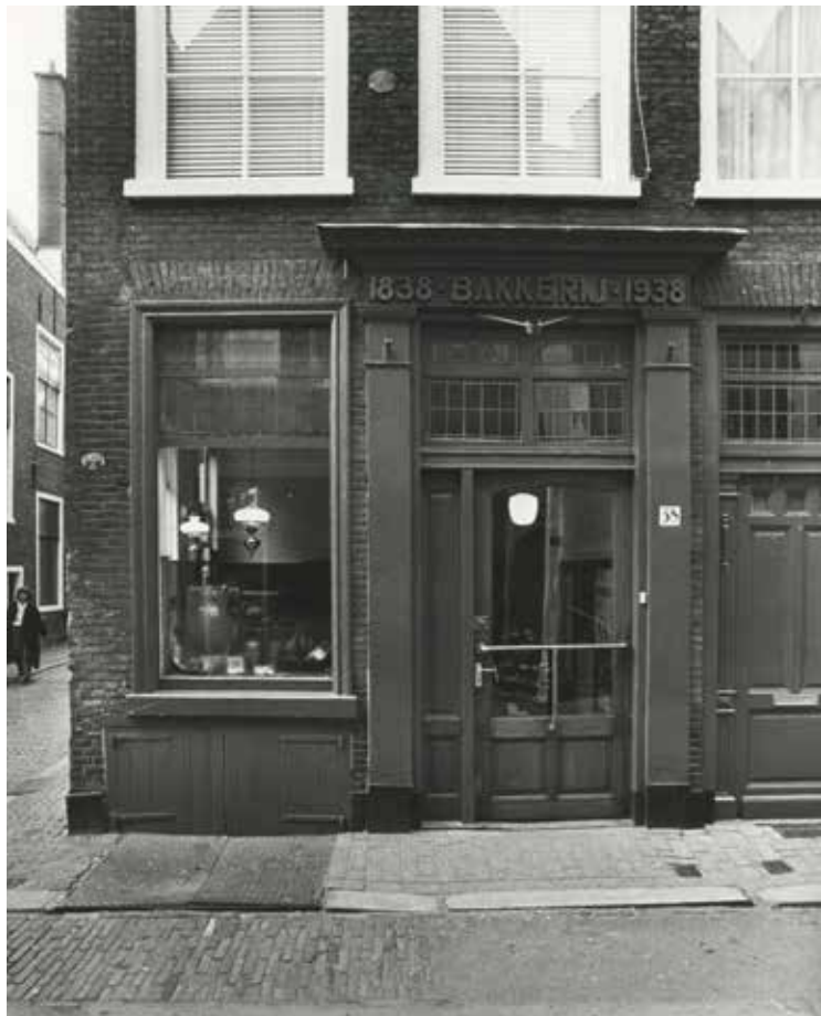
Winkelpand in 1978 waarop het aanvoerluik nog zichtbaar is
