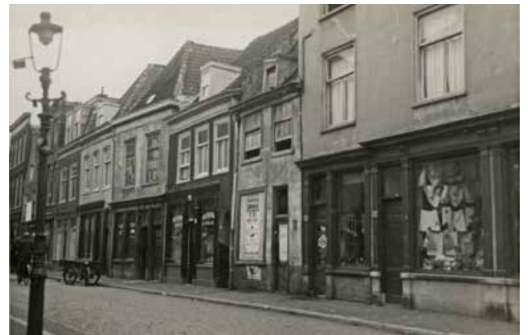
Geest, gezien van de Vleerstraat richting Torenstraat. Foto uit 1939, H.A.W. Douwes, collectie HGA
