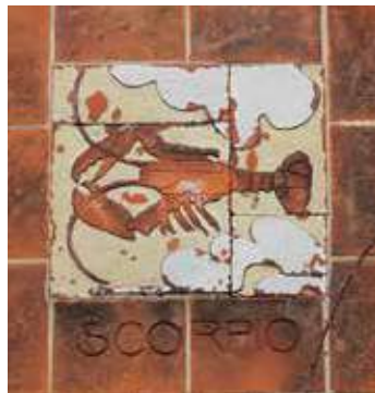
De foutief ingelegde gevelsteen op Kwartellaan 33. Foto: Jacqueline Alders, www.ikgidsudoordenhaag.nl
