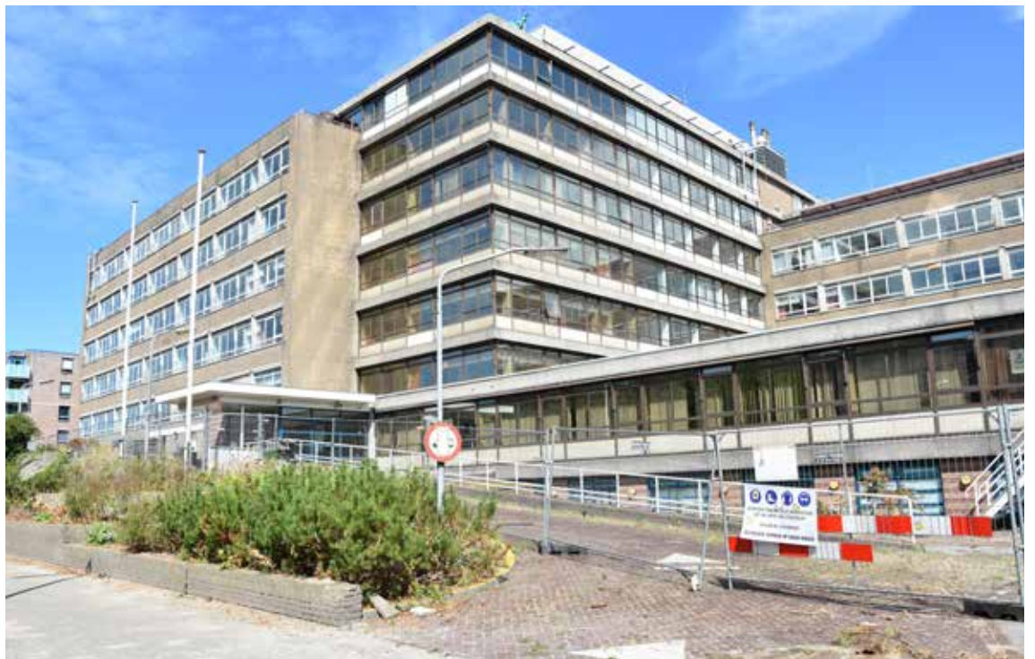
Lozerhof, Randweg 64, met op de voorgrond de hellingbaan naar de hoofdingang. Foto: Gina Dierckx, Haags Gemeentearchief
