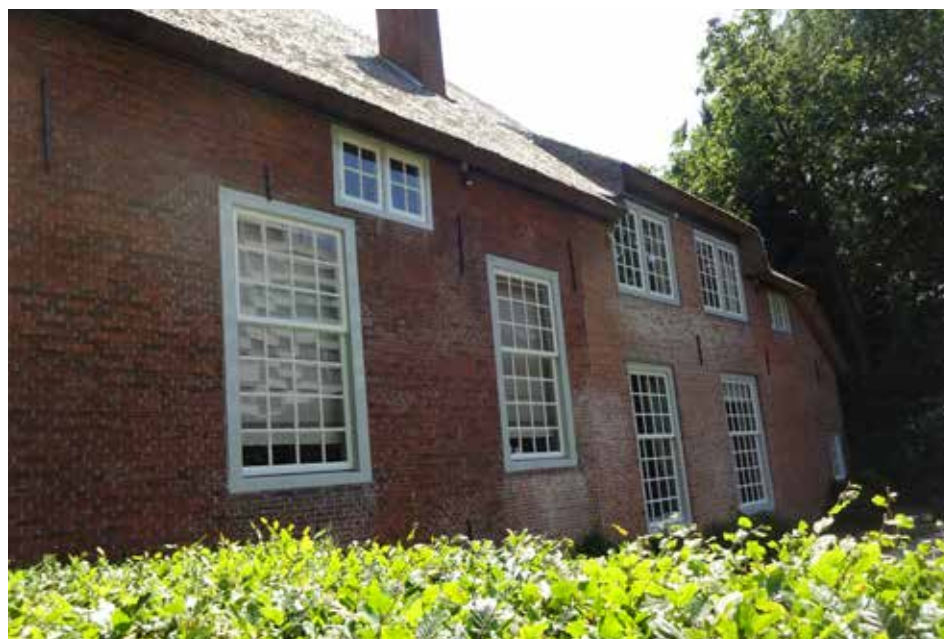
Achtergevel woning tuinman De Rietjes
