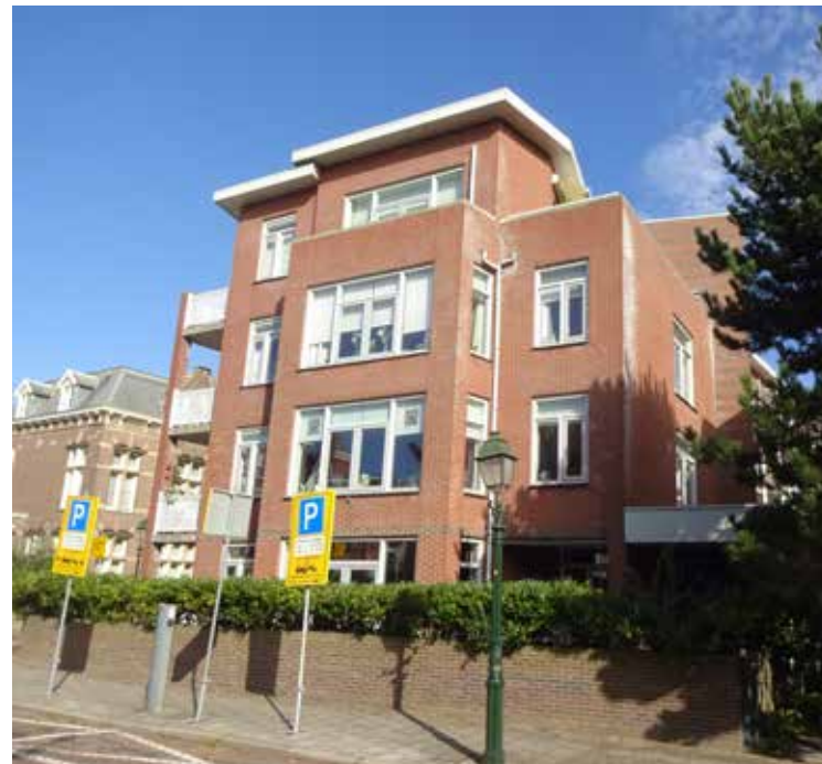
Van der Helmstraat (het oude pand is gesloopt)
