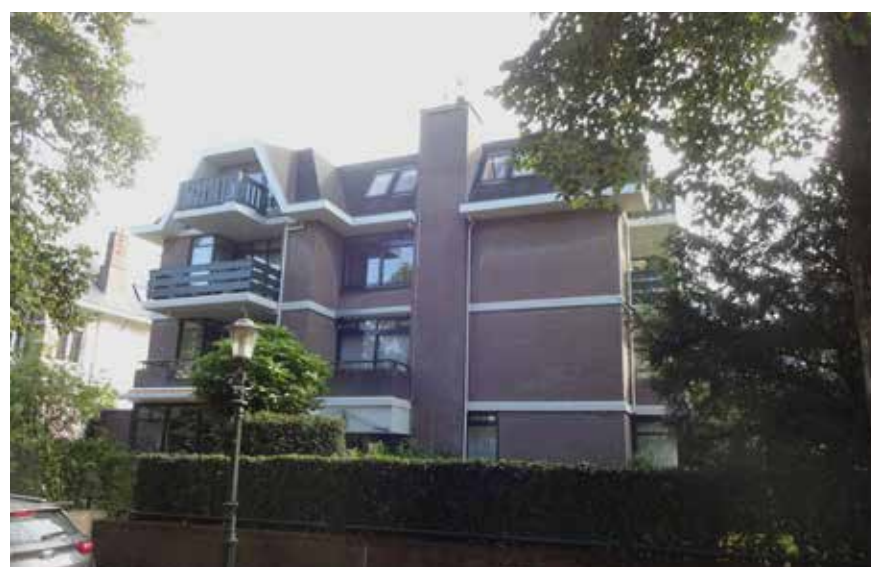
Parkweg 3 (het oude pand is gesloopt)
