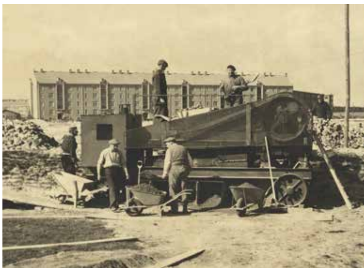
Heeswijkplein in aanbouw, op de achtergrond de Erasmusweg (tussen Troelstrakade en Moerweg). Foto uit 1950, Haags Gemeentearchief
