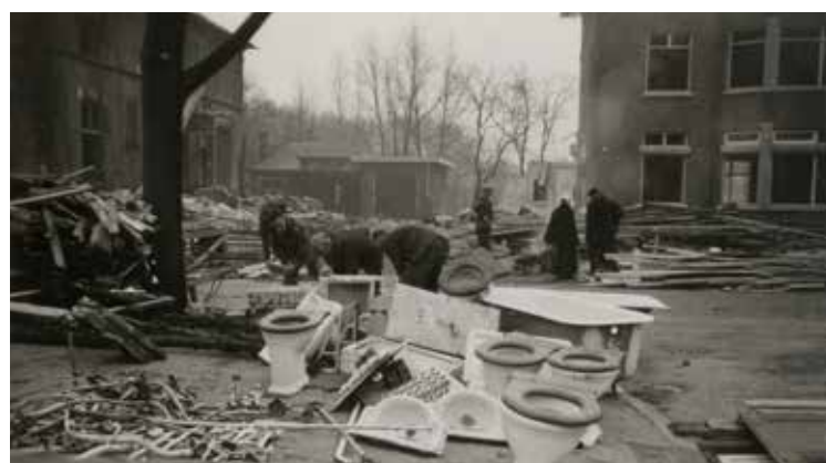
WC-potten afkomstig uit huizen aan de Stadhouderslaan. Bouwmaterialen die van de sloop vrij kwamen werden naar soort verzameld, naar depots gebracht en van daaruit per schip naar Duitsland afgevoerd. Hout werd door de Wehrmacht gevorderd. Foto: Haags Gemeentearchief
